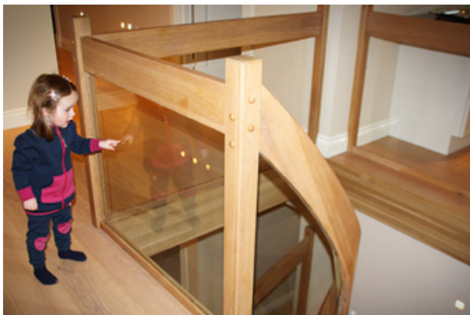
Foto: Newswire Et rekkverk av glass kan være en dødsfelle dersom det er brukt usikret glass.
